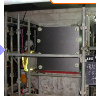
ステップ6 補強平板接着
