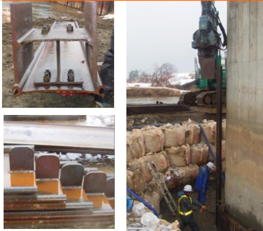
仮支点部材設置の一例
