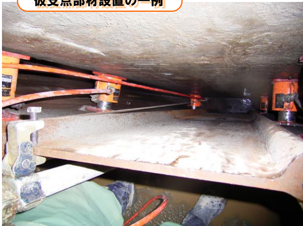
仮支点部材設置の一例
