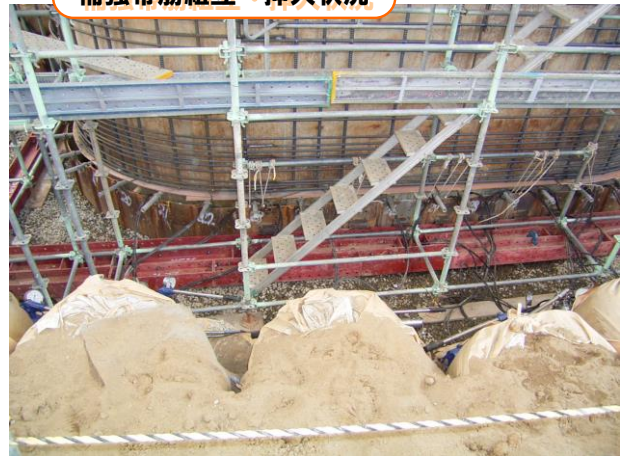
補強帯筋組立・挿入状況
