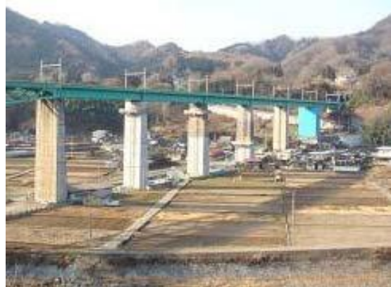
昇降式足場による新工法
