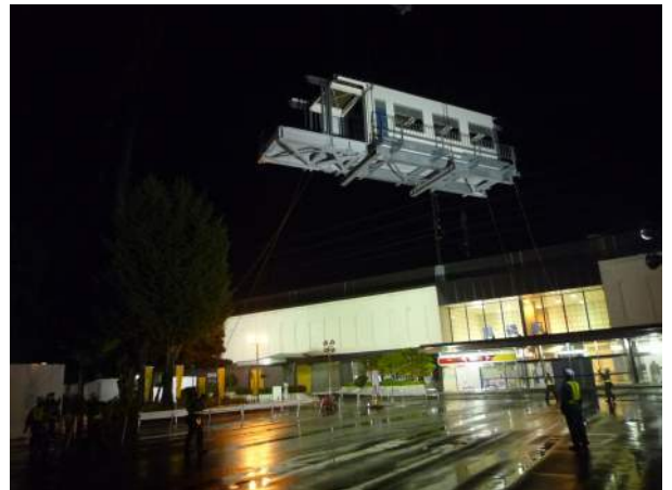
こ線橋新設状況
