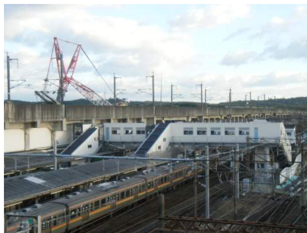
こ線橋設置完了
