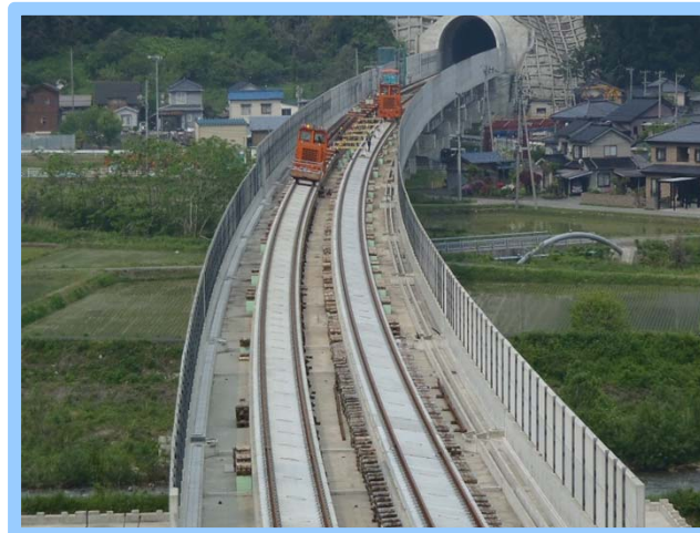
北陸新幹線（糸魚川工区）軌道敷設工事
