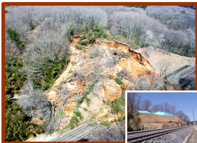
大震災復旧工事(東北本線 土砂崩壊)
