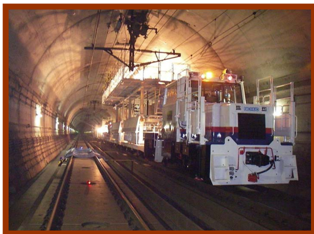
東北新幹線 トンネル耐震工事
