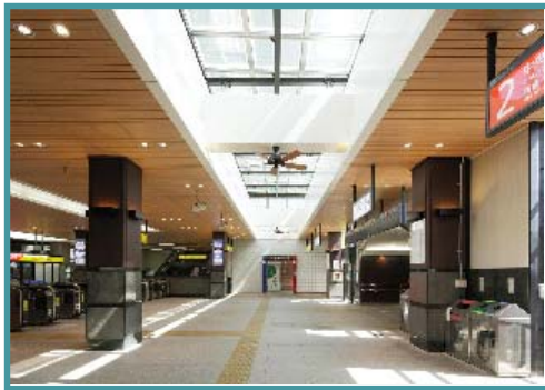
太陽光パネルと一体化した 採光用天窗
