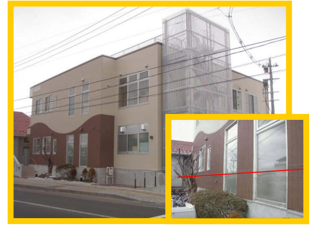
【復旧後】 (右下 冠水部分)
