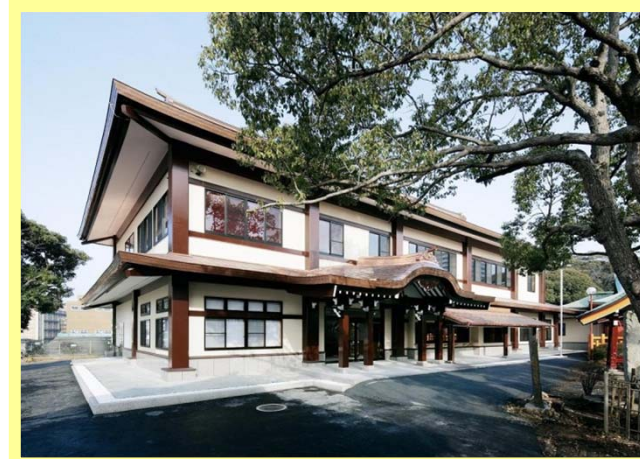
水戸東照宮 社務所新築工事
