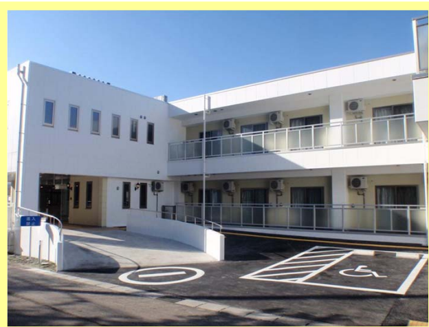
特別養護老人ホーム たらす鉤取新築工事 (宮城県 仙台市)
