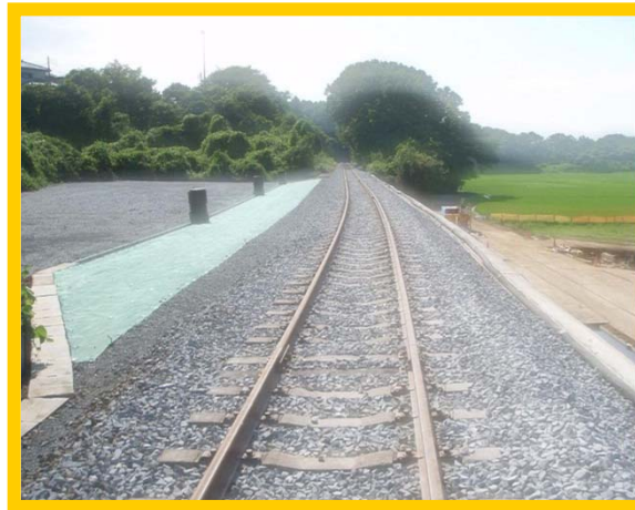
【復旧工事完了】
