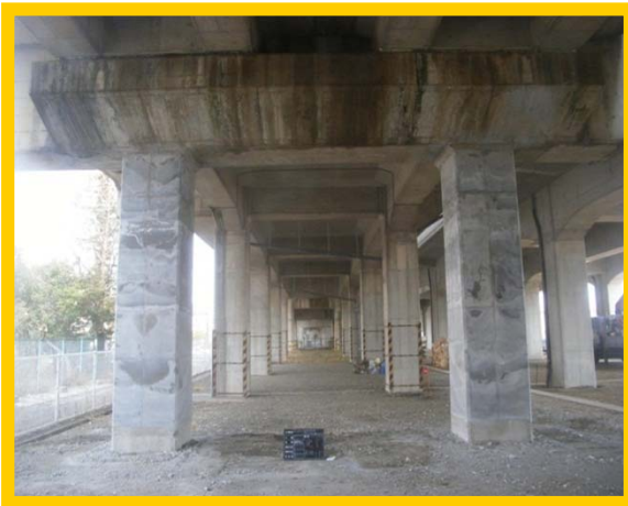
【復旧処置完了】
