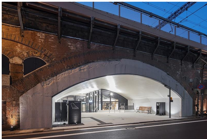
日比谷OKUROJI新築工事
