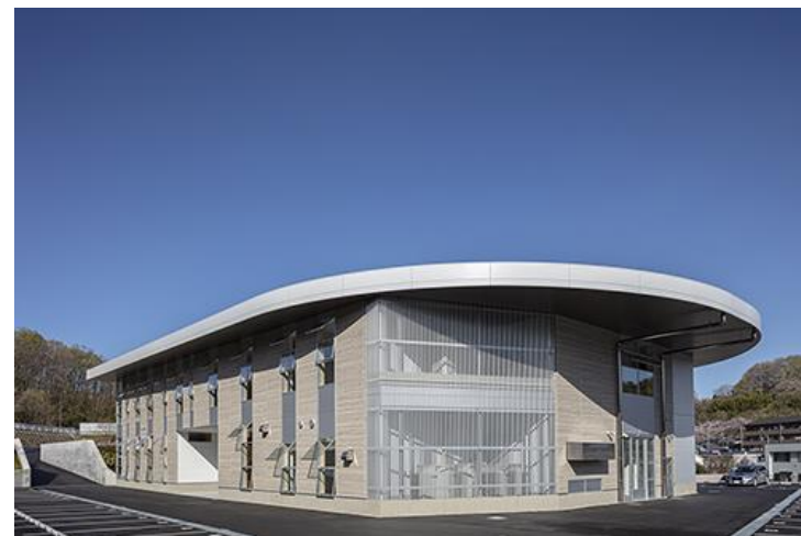
ヤマデンNSJ新築工事
