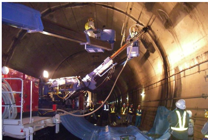
新幹線トンネル耐震補強工事 「新STARS」
