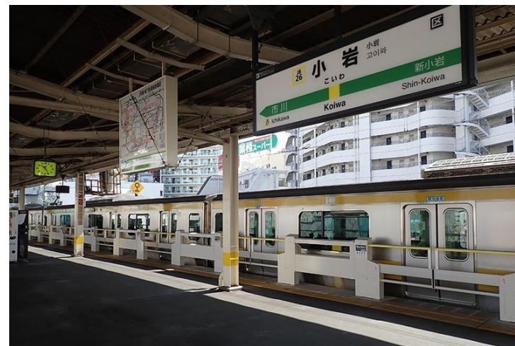
JR総武線（スマートホームドア®） JR小岩駅ホームドア新設に伴うホーム改良工事
