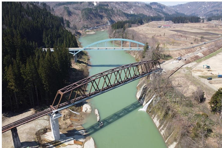
JR只見線 第七只見川橋りょう災害復旧工事
