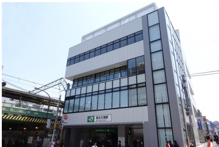
新大久保駅 駅舎改良工事
