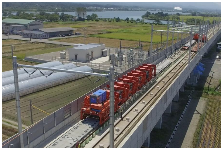
北陸新幹線 小松軌道敷設
