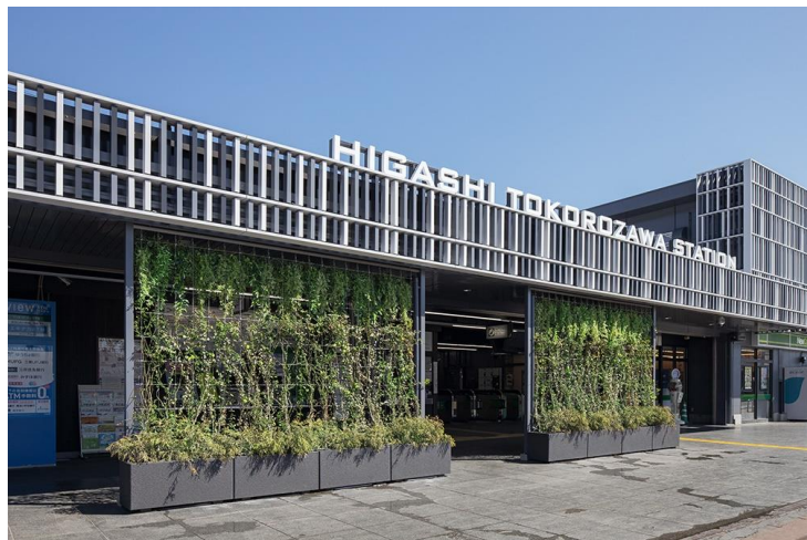
JR武蔵野線 東所沢駅 リニューアルに伴う壁面緑化工事
