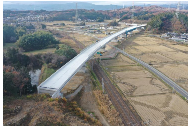
小名浜～常磐自動車道 常磐自動車道 小名浜道路新設工事
