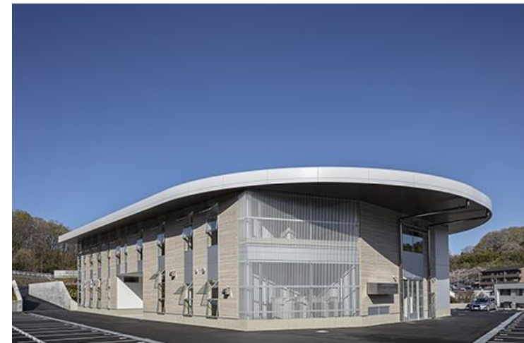
ヤマデンNSJ新築工事
