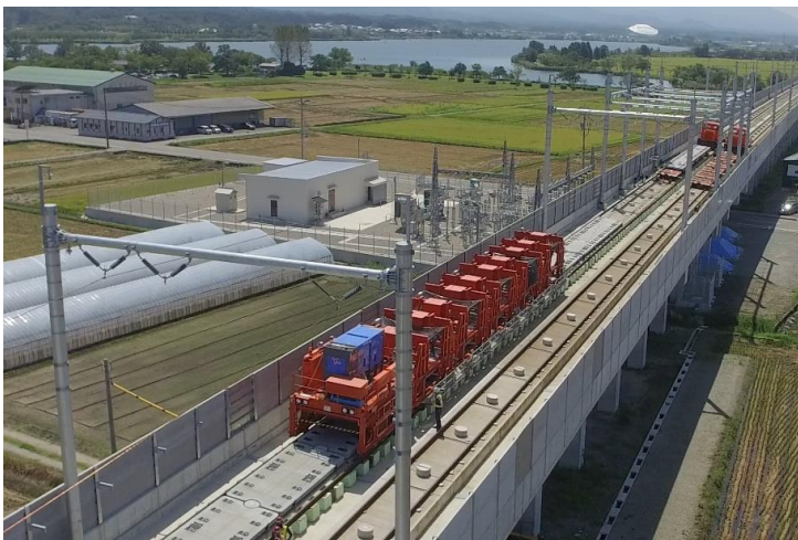
北陸新幹線 小松軌道敷設
