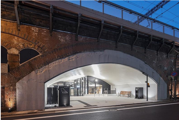
日比谷OKUROJI新築工事
