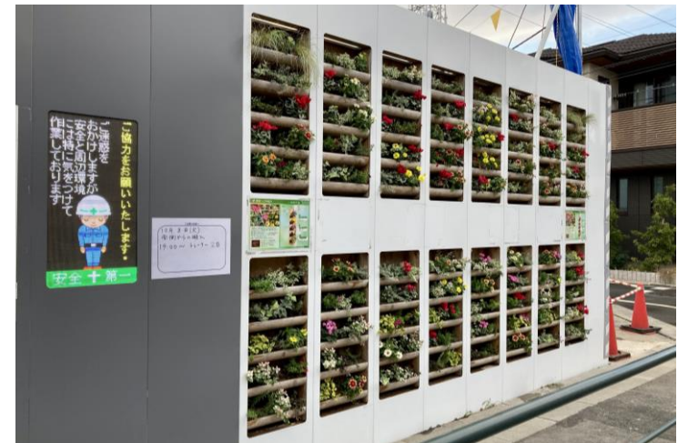
仮囲い壁面緑化 マンション建設現場
