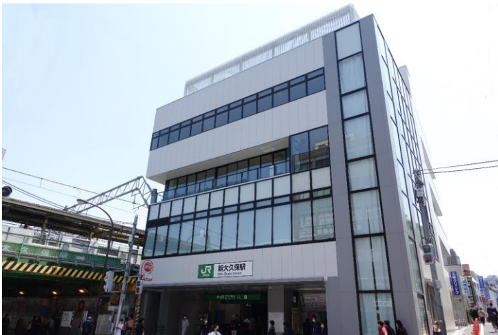
新大久保駅 駅舎改良工事
