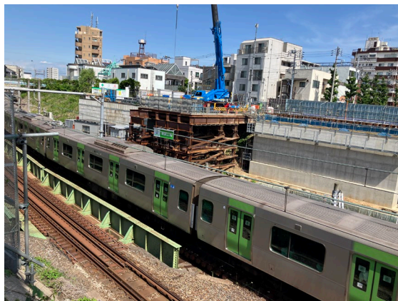
施工箇所は街中で、直下を電車が走行
