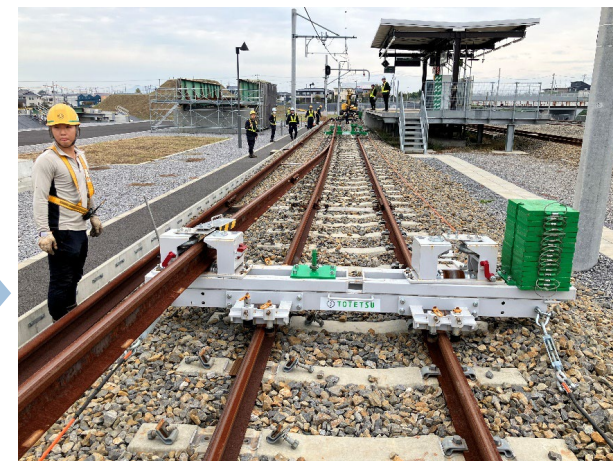
牽引式レール交換機を使用した作業
