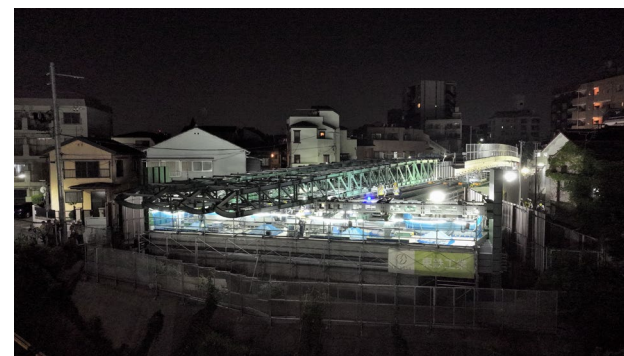
送り出しによる橋梁の架設
